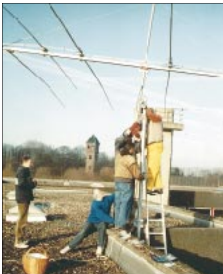
Am Rande des Flachdaches konnte in diesem Frühjahr der 7-Ele.-Fünfband-KW-Beam aufgebaut werden.
